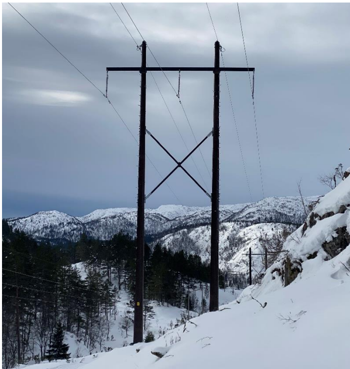
Figur 5-6. Bildet viser en komposittmast.
