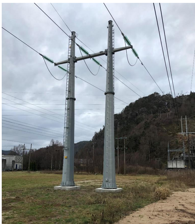
Figur 5-7. Bildet viser en rørmast i stål. Slike master vil brukes ved lange spenn, vinkler og som forankringsmaster.
